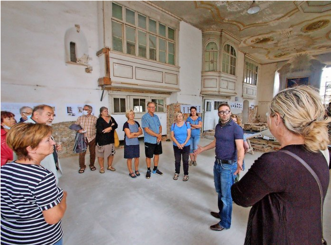
Offene Baustelle: Baupfleger Tilmann Dorn informierte am Freitag über den Stand der Restaurierungsarbeiten. Foto: Roger Dietze
